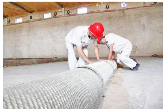
6月1日,位于河南省夏邑县会亭镇的河南世通谷物有限公司夏邑直属库员工在检修地面通风笼。 王高超 摄
